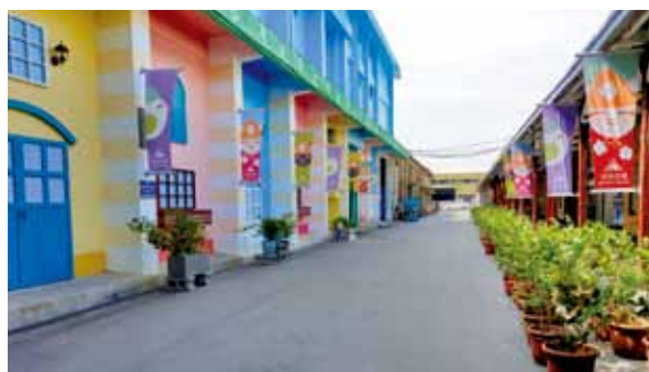
老倉庫再利用—倉庫牆面彩繪
