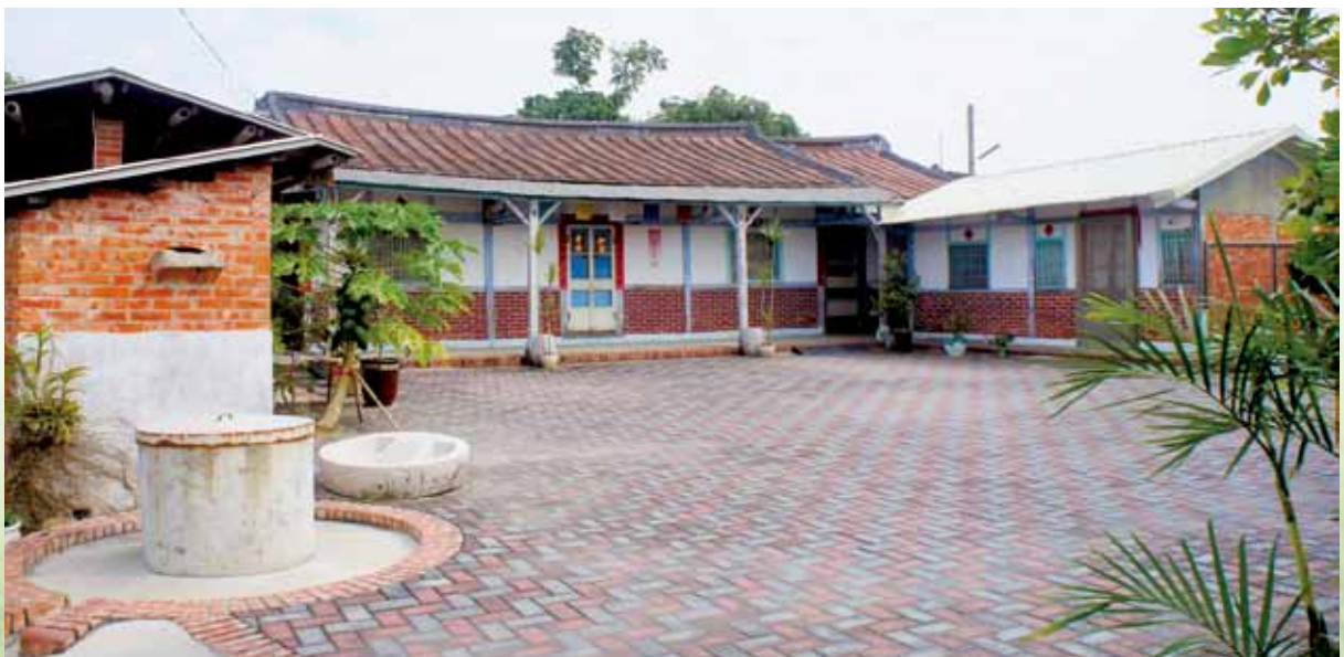
閒置老舊的三合院整修活化空間再利用，作為綠建築的典範
