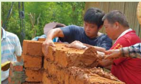
傳統工法土塼厝實作
