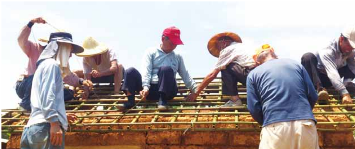
傳統工法土塼厝實作
